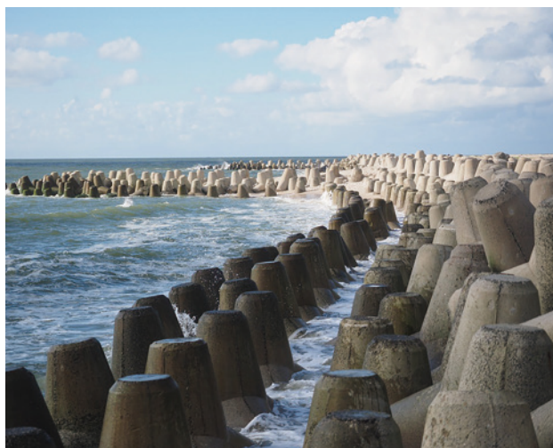
tetrapod [ˈtɛtrəˌpɑːd] (n.) 消波塊能吸收並減弱海浪的衝擊，保護海岸不受侵蝕。
